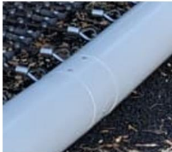
Zdjęcie przykładowej osłony węzła konstrukcji stalowej
